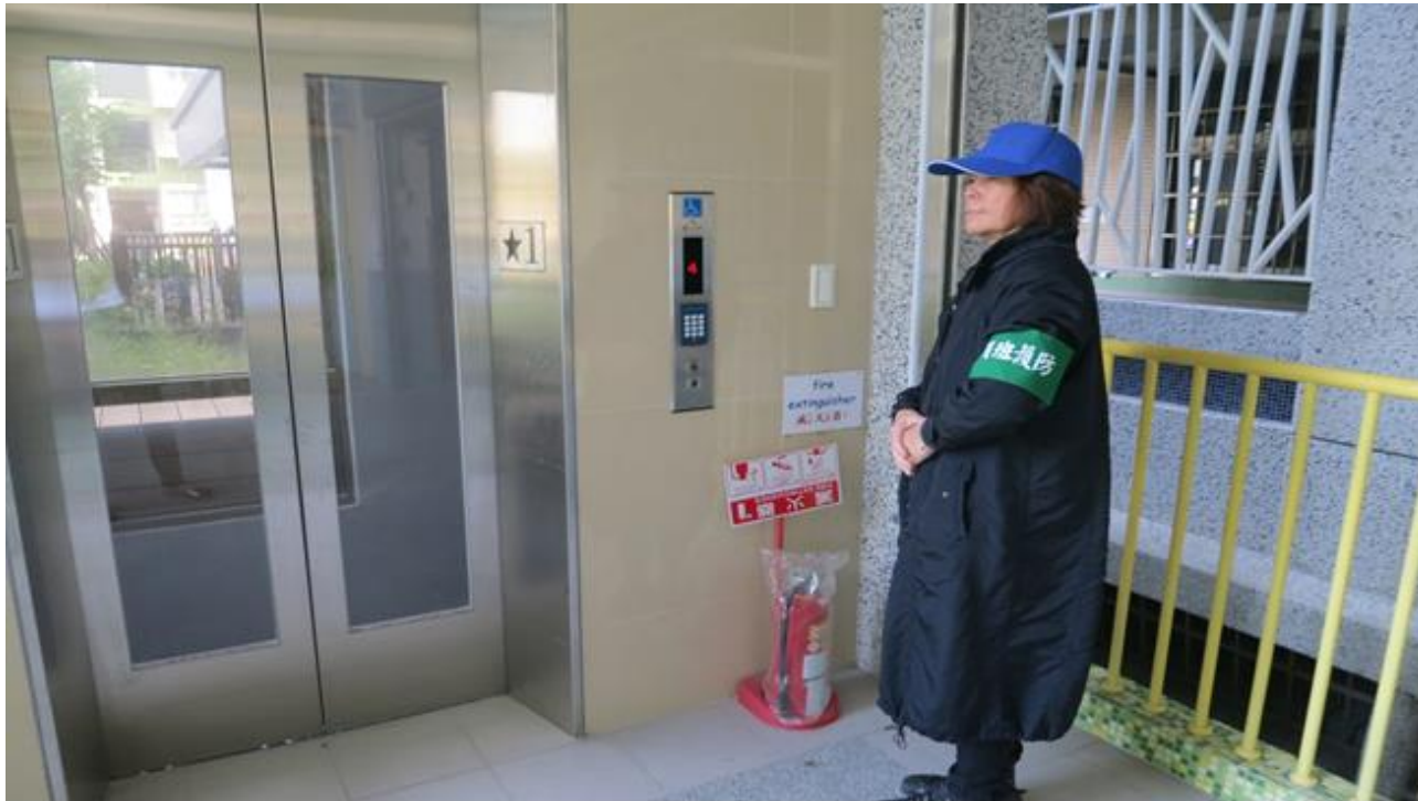
安全防護電梯關閉
